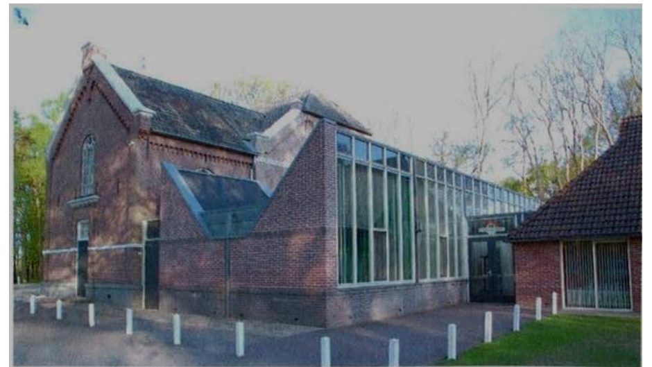
Nieuwbouw 't Middelpunt 2005
