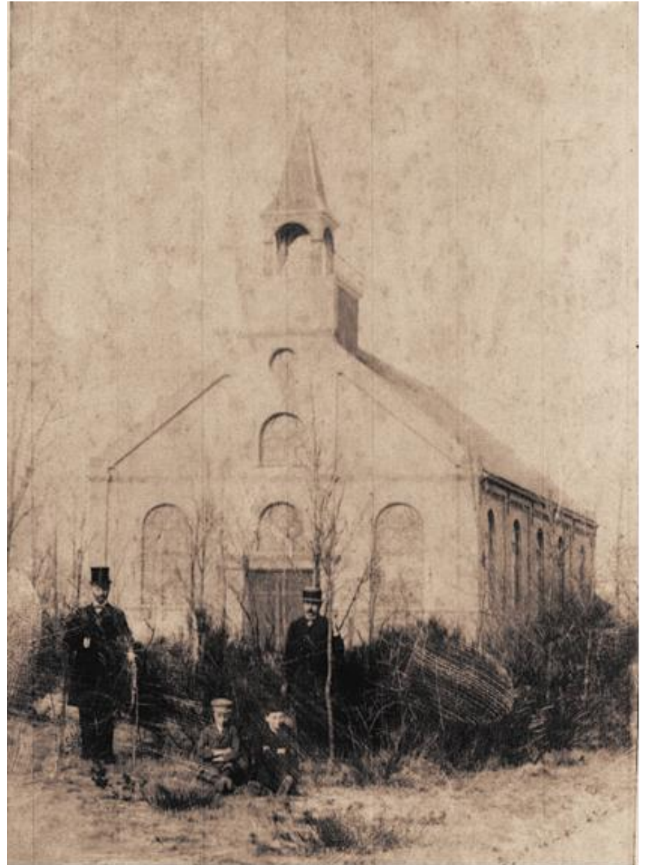
Foto van het kerkgebouw van voor 1912
